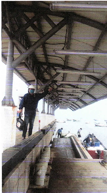
FOTO N°04 OBSERVA TODA LA COBERTCABEZO TERMINADAURA DEL AREA DEL
