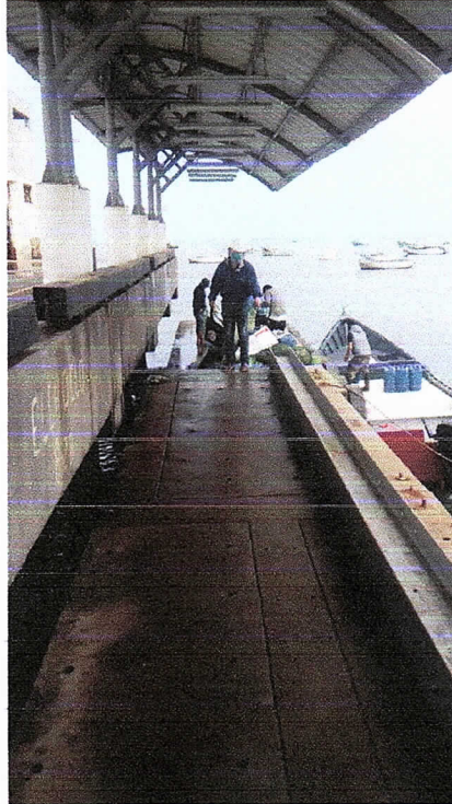
FOTO N°03 SE OBSERVA VIGA ESTRUCTURAL PARA SER COLOCADA ENTRE PILOTES
